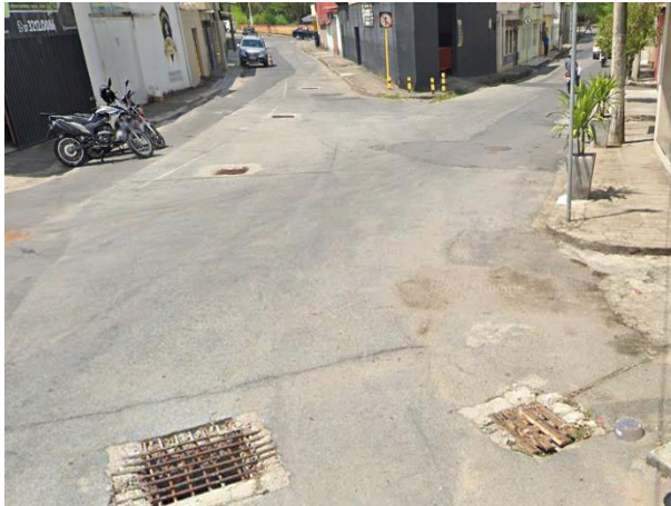
Trecho do córrego canalizado
