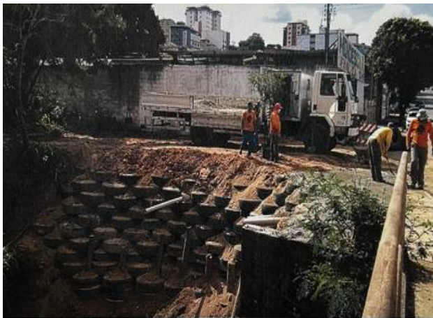
Construção de pneus “riprap” no córrego Flecha
