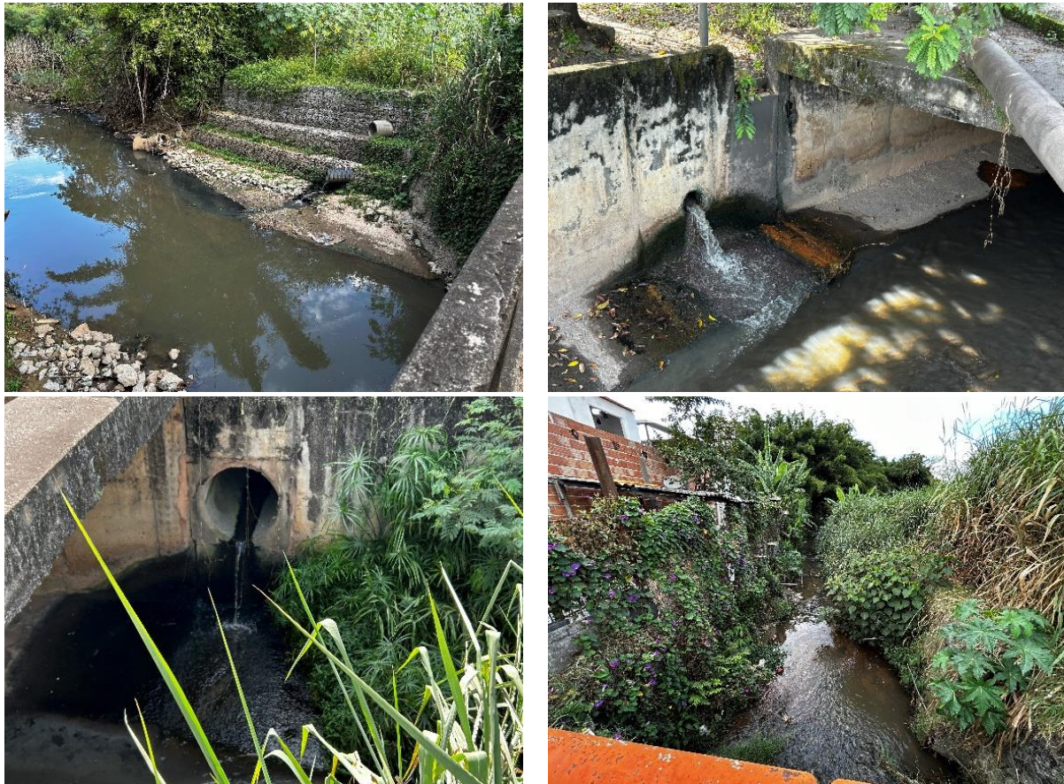
Figura 27 - Lançamentos de esgoto na macrodrenagem. Fonte: SERENCO.
