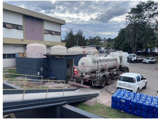
Armazenamento de produtos químicos
