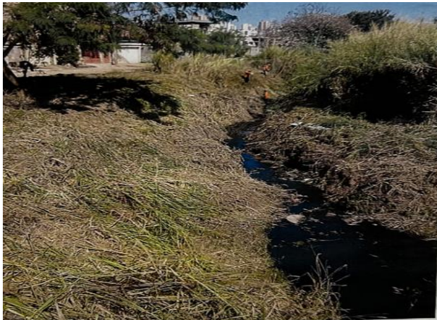
Limpeza, manutenção e desassoreamento
