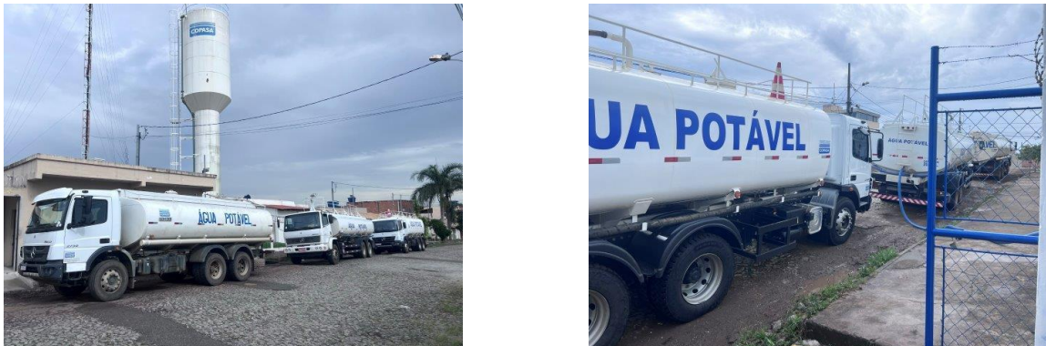
Figura 42 - Abastecimento do Reservatório R7 por caminhões pipa.
