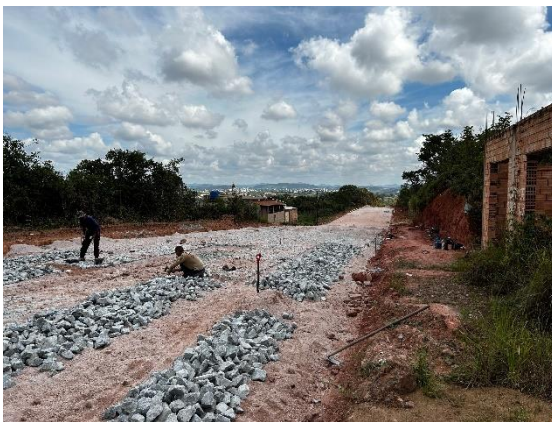
Via com pedra irregular (em construção)
