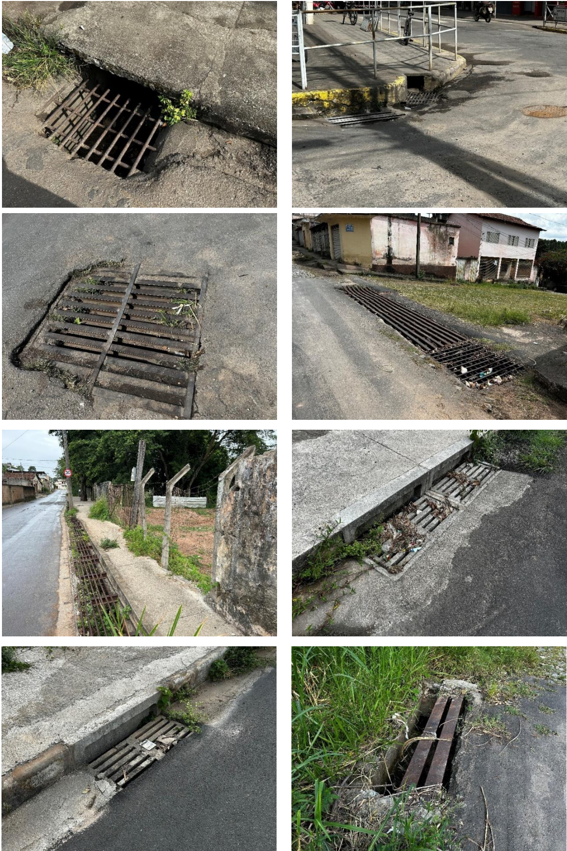
Figura 9 - Diferentes tipologias de bocas de lobo, bueiros e sarjetas do município de Divinópolis. Fonte: SERENCO.
