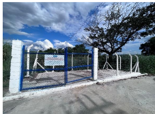
ETE Jd. Real - poço para retirada por caminhão
