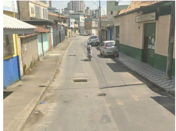
Trecho do córrego canalizado
