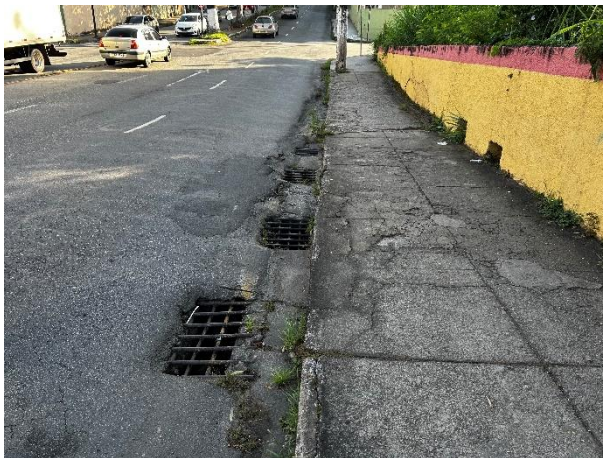
Bocas de lobo acima da Galeria da Avenida JK
