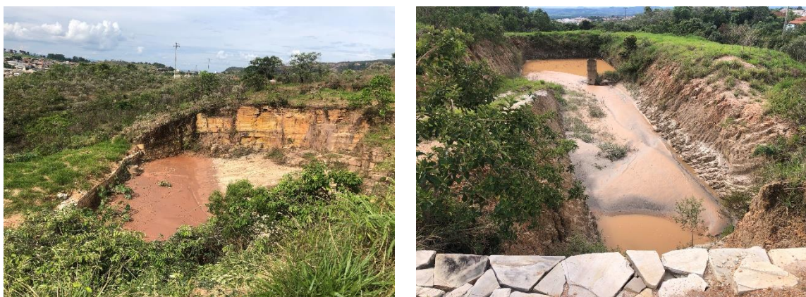
Figura 44 - Exemplo de Bacias de amortecimento de cheias (bacias de detenção) em loteamento. Fonte: SERENCO.
