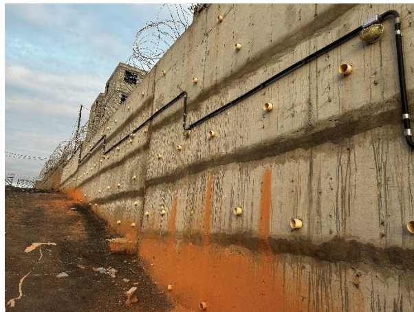
Concreto com sistema drenante
