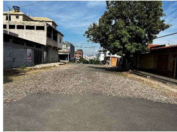
Via com pedra irregular e asfalto
