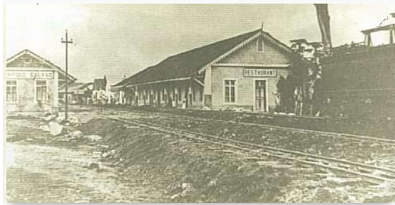
Figura 4 - Construção da Estrada de Ferro Oeste de Minas.
