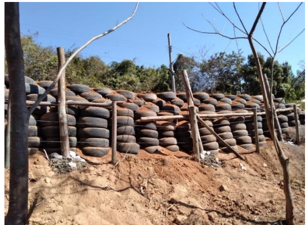
Rip rap com pneus e madeira
