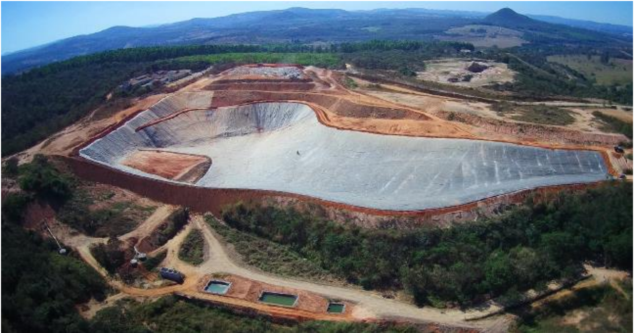
Figura 28 - Imagem aérea após a finalização das obras de adequações.
