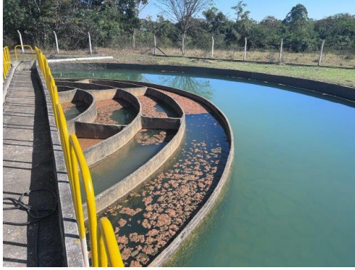
Floccodecantador
