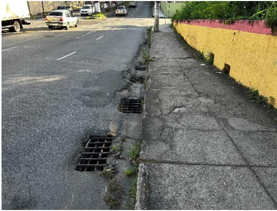
Via asfaltada com sarjeta e boca de lobo
