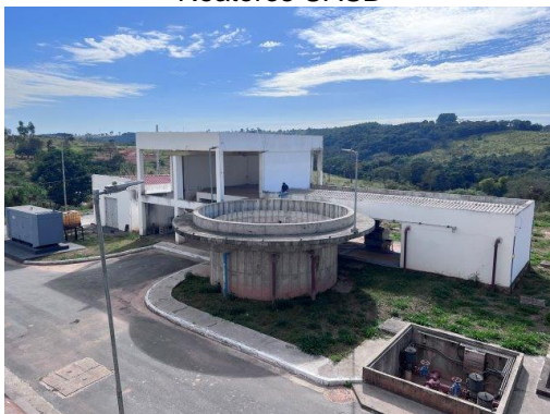
Desidratação do lodo
