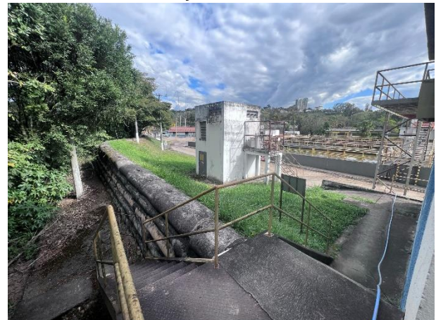
Rip-rap de contenção de solo-cimento
