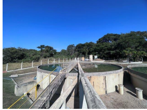
Floccodecantador
