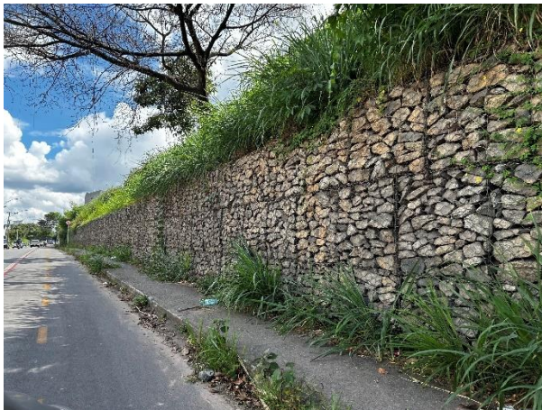
Muro de Gabião
